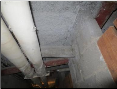
Photo N° 1085 AMIANTE CIMENT -- COULOIRS DE CAVES Conduits de fluide Chute E.U.(Fibres-ciment) X2
